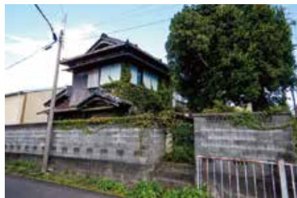
▲市街地でもどうにもならない空き家
